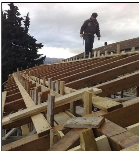
Orditura di tetto con struttura lamellare
