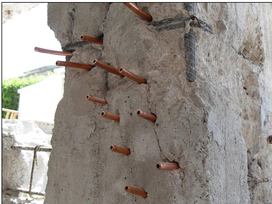
**Iniezioni di resine epossidiche per consolidamento preliminare del calcestruzzo per applicazioni di fibra di carbonio**
